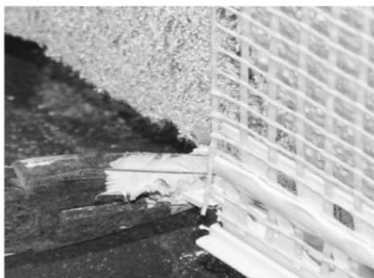
Wyrównanie łącznika profilu
