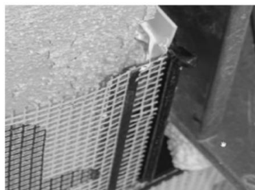
Zamontowany narożnik z łącznikiem Sto-Fugenflankenprofil
