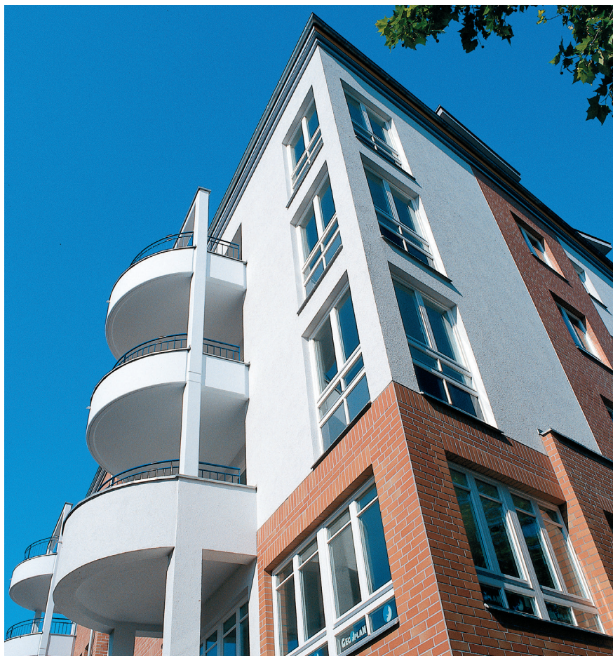
Zastosowanie systemu StoTherm Ceramic na fragmentach elewacji znacznie podnosi walory estetyczne budynku.
