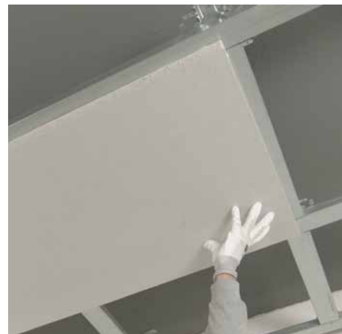
Dociskanie płyty akustycznej
