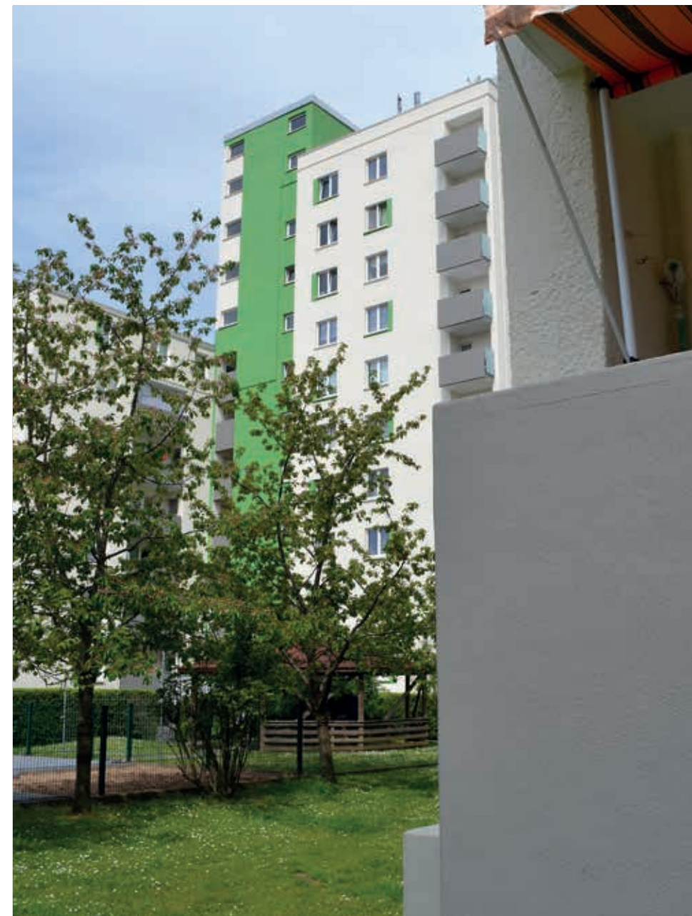
Osiedle mieszkaniowe, Hanau, DE Inwestor: Schlag Immobilien GmbH, Hanau, DE Koncepcja kolorystyczna: StoDesign Systemy StoCretec: StoFloor Balcony Waterproof DL 300, StoConcrete Protect V, StoConcrete Repair Prime SM Zdjęcie: StoCretec GmbH
