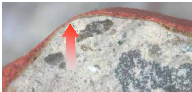
Nieprawidłowo: Jednokrotne malowanie farbą skutkuje zbyt małą grubością powłoki na ostrych krawędziach ziaren.
