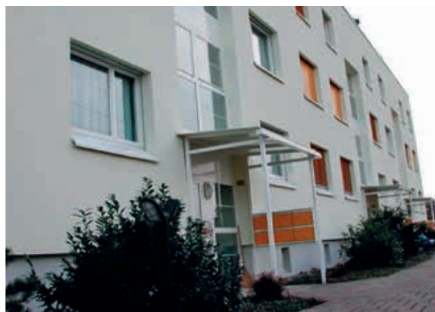
Ten sam budynek po 6 latach od renowacji farbą StoColor Silco G.
