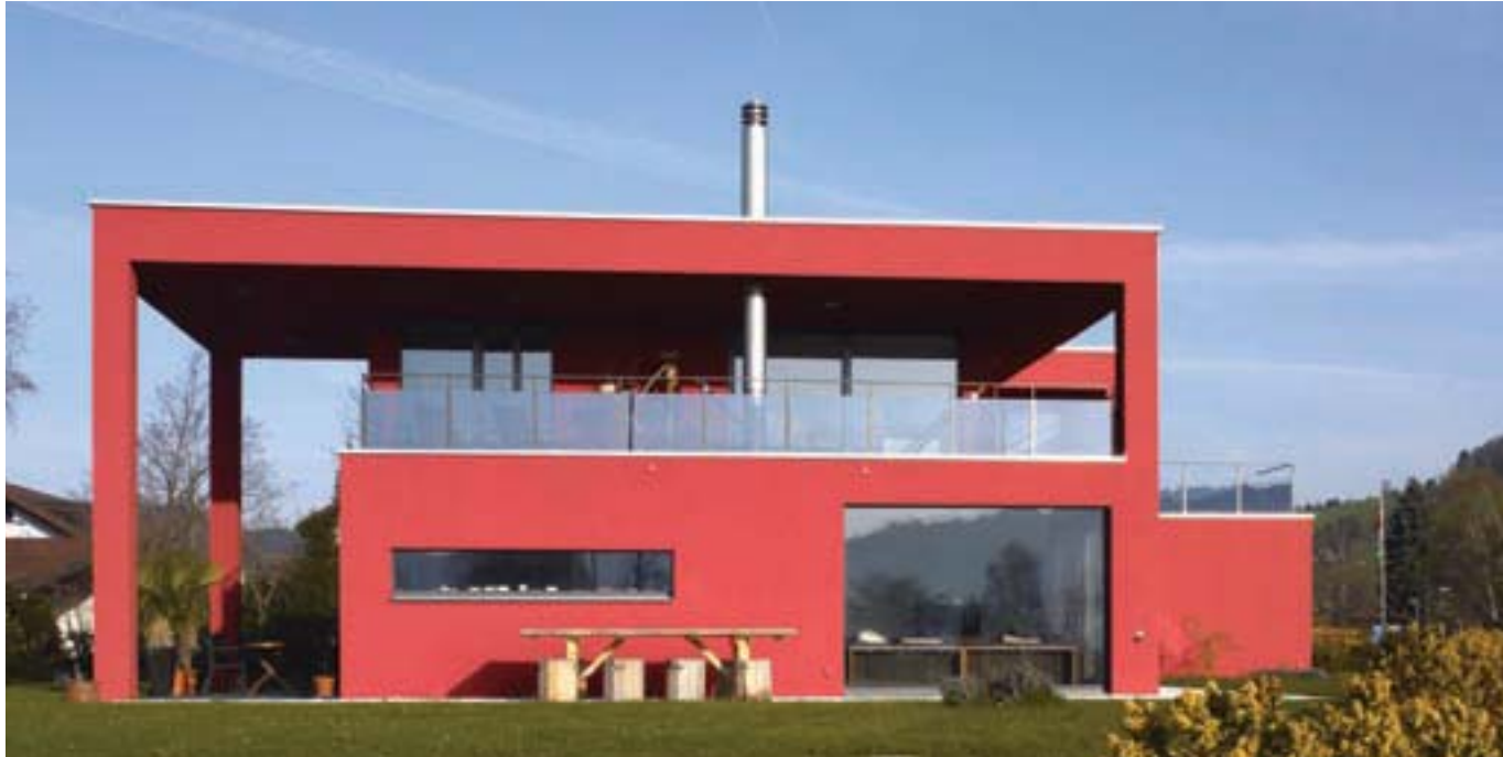
StoTherm Classic – uznany na całym świecie system ociepleń z izolacją ze styropianu – w połączeniu z farbą StoColor X-black. Współczynnik odbicia światła rozproszonego <20%
