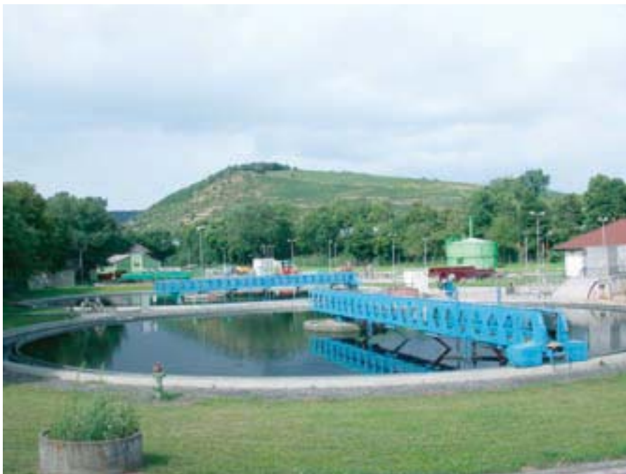
StoFlexyl sprawdza się doskonale jako uszczelniająca powłoka, zabezpieczająca od wewnątrz zbiorniki na wodę
