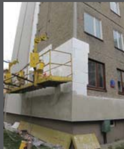
Termomodernizacja jednego z budynków
