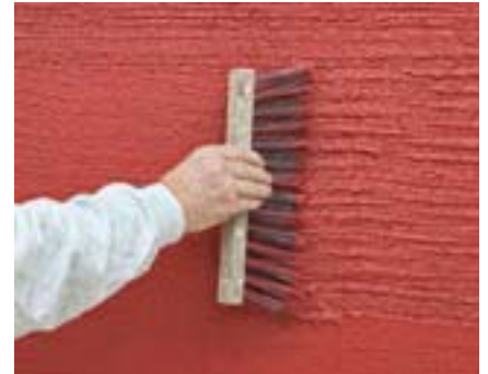
Następnie pociągnięciami szczotką po jeszcze mokrym tynku nadawana jest struktura powierzchni.
