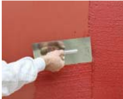
Akrylowy tynk wierzchni StoDecolit Effect (tutaj w kolorze 10DC310 z kolekcji Designer Collection) nakładany jest za pomocą pacy na grubość ziarna.
