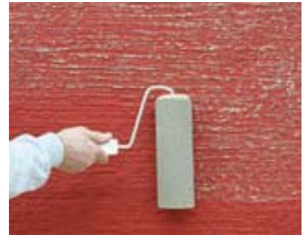
... na wierzchołki struktury za pomocą wałka gąbkowego zostaje nałożona powłoka z efektem metalizującym StoColor Metallic (w kolorze 10DC73M z kolekcji Designer Collection).
