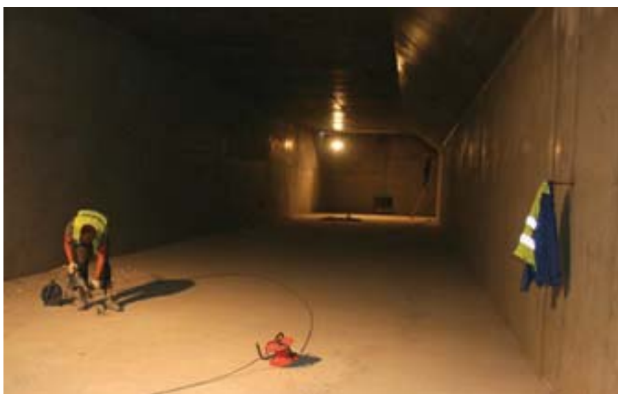
Wnętrze zbiornika ppoż stadionu PGE Arena w Gdańsku
